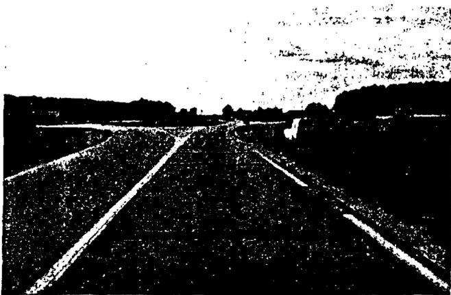
**Le rôle** des bandes rugueuses est d'attirer l'attention du conducteur afin que celui-ci, à la vue de la signalisation et du danger, adapte sa vitesse à la configuration du
