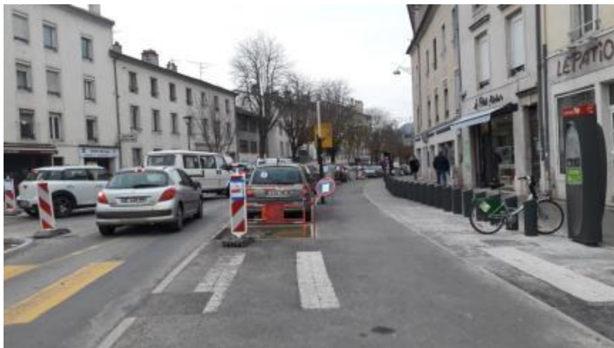
Deux pistes cyclables unidirectionnelles, Faubourg des 3 Maisons, Nancy (en travaux) : 650 ml
