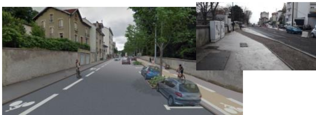
Bande cyclable et piste cyclable, avenue Libération, Nancy (en travaux) : 1,1 km
