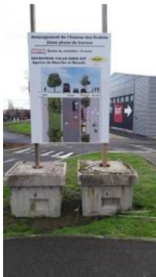
Voie verte, 2 ème section, avenue des Erables, Heillecourt (en travaux) : 900 ml
