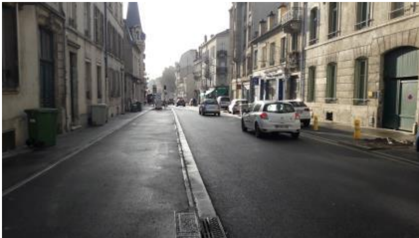
Piste bi-directionnelle, rue Jeanne d'Arc, Nancy (en travaux)
